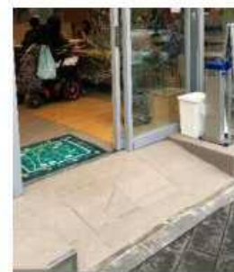
スロープの設置
