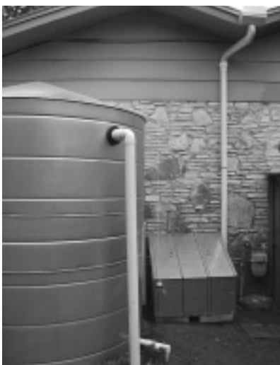
屋根に降る雨水をパイプでタンクの中に集める
