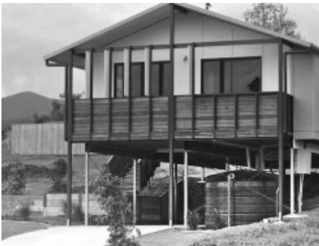
家の下に設置された雨水タンク
